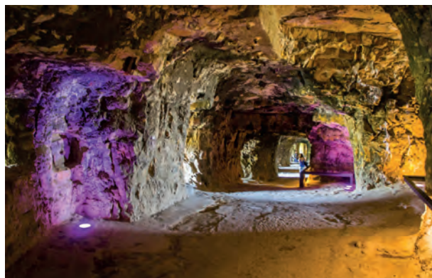
Die Kasematten, ein unterirdisches Höhlen- und Wegesystem, beherbergte früher auch Werkstätten, Küchen und Bäckereien
